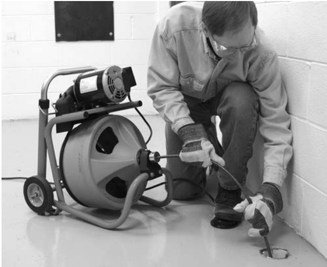
Figura 12 – En posición correcta para trabajar: operario se encuentra alimentando el cable manualmente
