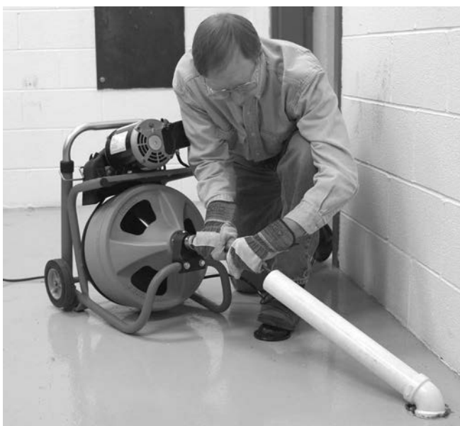
Obrázek 9 – Příklad prodloužení odpadu na vzdálenost 2' od vstupního otvoru odpadu
