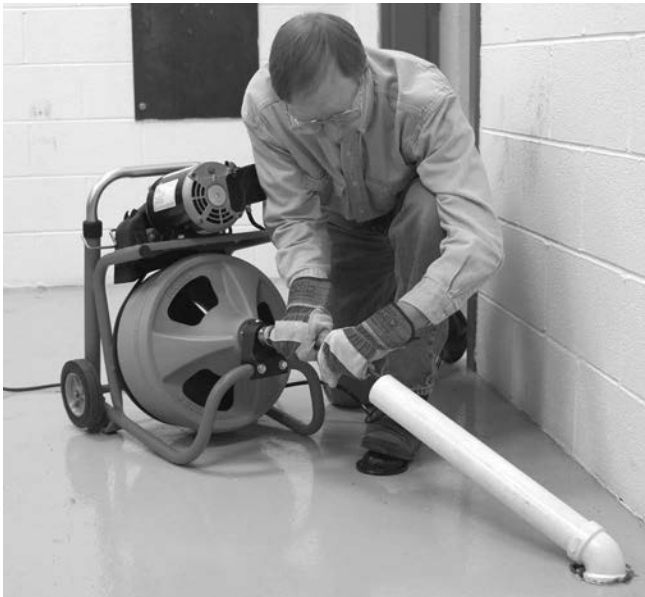
Figuur 9 – Voorbeeld van een verlenging van de afvoer tot minder dan 2' van de afvoeropening
