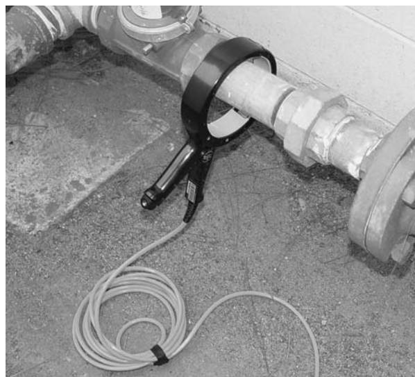
Figure 4 – Exemple de positionnement de la pince à induction
