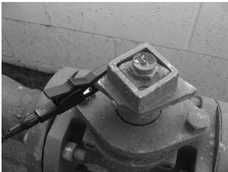
Рис. 7: Соединение прибора ST-305 с магистралью
